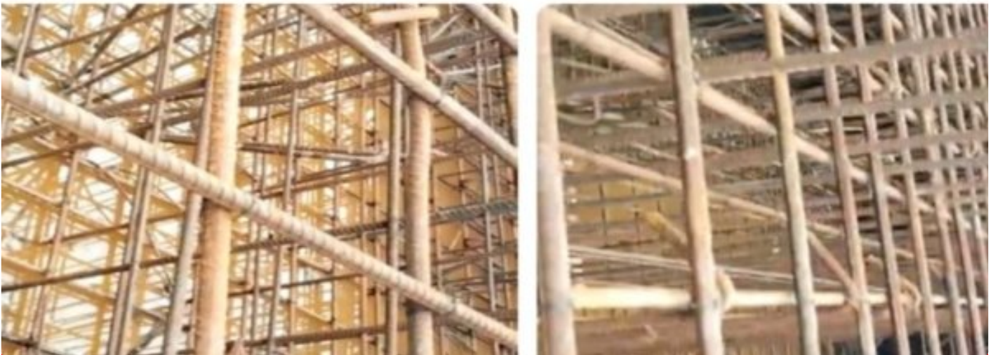
Proyek Jembatan Gantung
