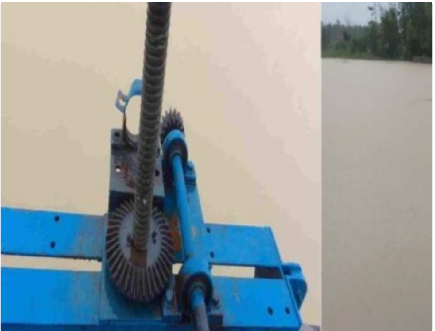
Pintu air Albaret Simpang Mesuji
